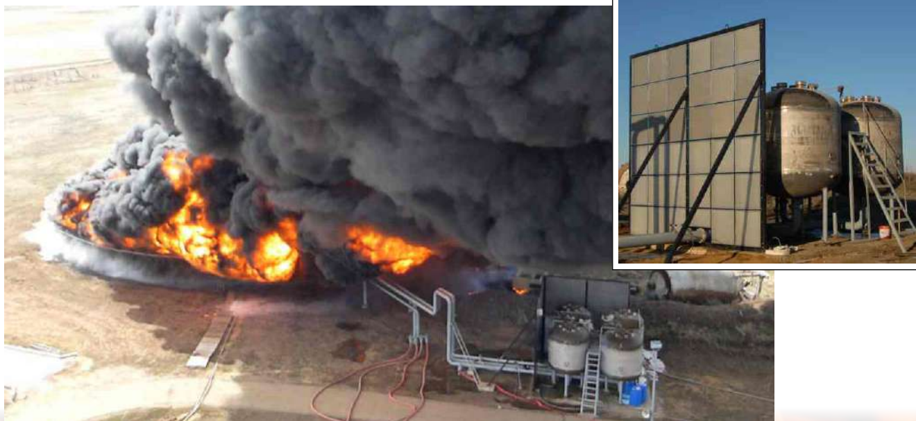
Применение противопожарной преграды «Согда» при тушении горящего резервуара
